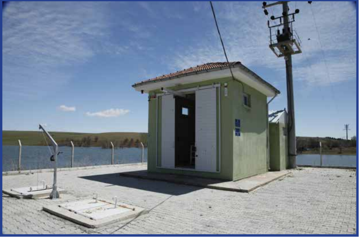
DÜZAĞAÇ TERFİ İSTASYONU
